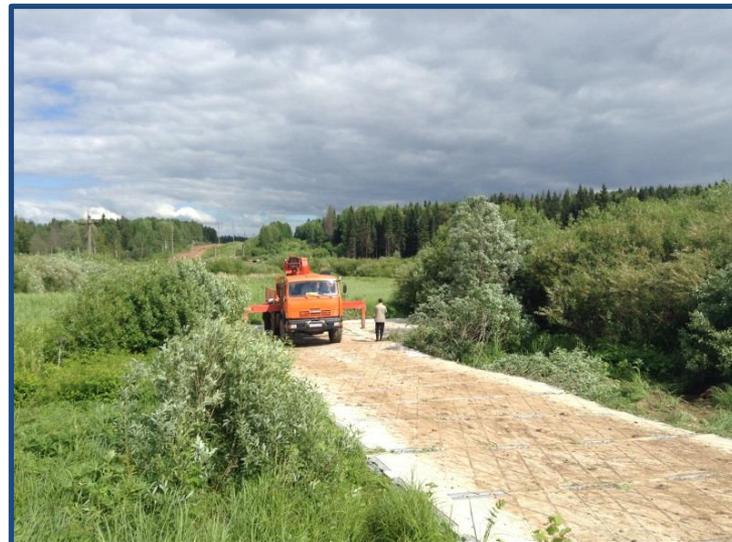
Укладка и сборка МДП Р-ТЭК на неподготовленном участке с естественной неровностью до 0,5 м, местами на кустарник высотой до 2,5 м.
