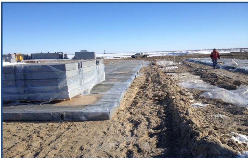
Монтаж и использование ПД Р-ТЭК в качестве лежневой опоры под направляющие балки основания буровой установки БУ5000/320 для кустового бурения скважин.
